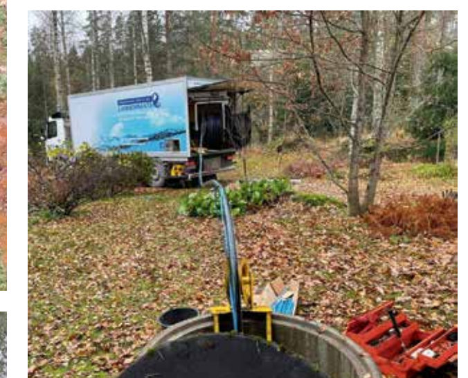
Lamminrannan puhdistuskalusto. Puhdistuskaluston ei tarvitse päästä kaivon viereen, voi jäädä 30 metrin päähän kaivosta.
